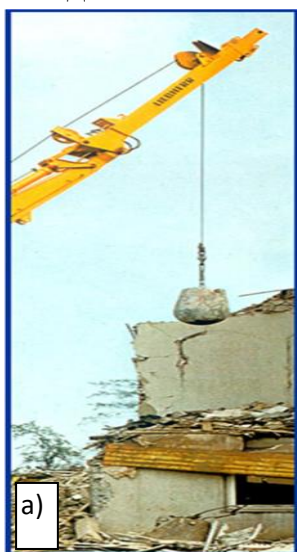
1.1- сурет - Ғимараттың шар-соққы (а) көмегімен бұзылуы және экскаватордың гидрожүйесіне қосылған гидравликалық құралдың (б) жұмысы.
