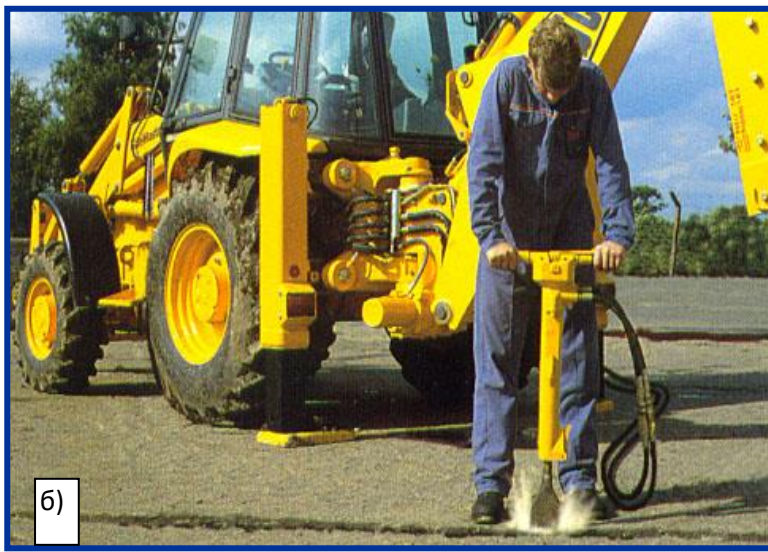
1.1- сурет - Ғимараттың шар-соққы (а) көмегімен бұзылуы және экскаватордың гидрожүйесіне қосылған гидравликалық құралдың (б) жұмысы.
