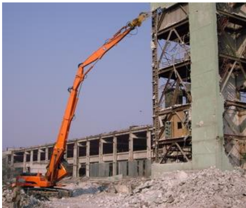
1.16- сурет - Биіктікте жұмыс істеу үшін экскаватор жебесіне гидрожинағыштарды орнату
